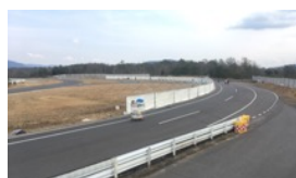
高速道路を再現！！ 最終コーナーに壁をつくり、現場の雰囲気
